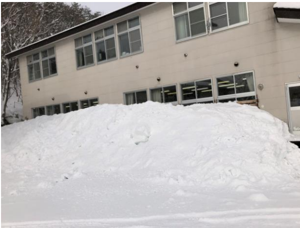
新校舎東側の様子、教室内も薄暗い
